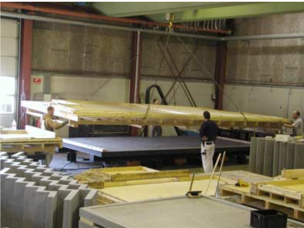
På øverste billede ses en trappe til det nye kontor for Arkitektgruppen Århus. På nederste billede kan et par trappeløb ses i forgrunden, mens en form til altanplader løftes på plads i baggrunden hos Hi-Con.
