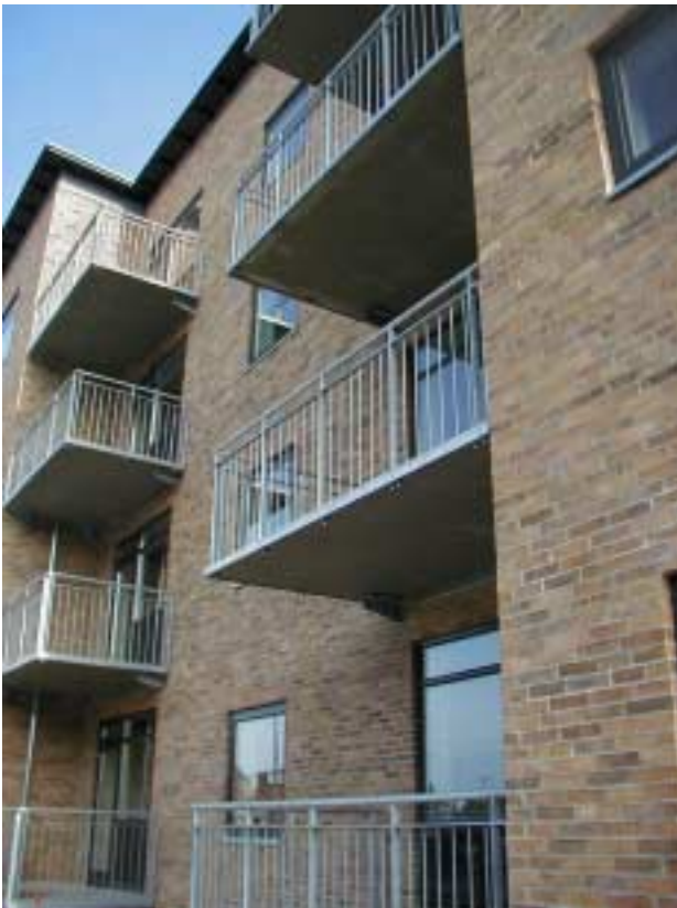
CRC-altaner på Vognfjederen, København produceret af PL Beton. Altanerne er understøttet på 3 punkter. Arkitektgruppen Århus var arkitekter.
