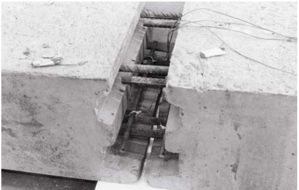
Detalje af samlingen før udstøbning. Armeringsjernene er udstyret med strain gauges af hensyn til målingerne under forsøgene, der blev udført på Chalmers Universitet, Göteborg.
