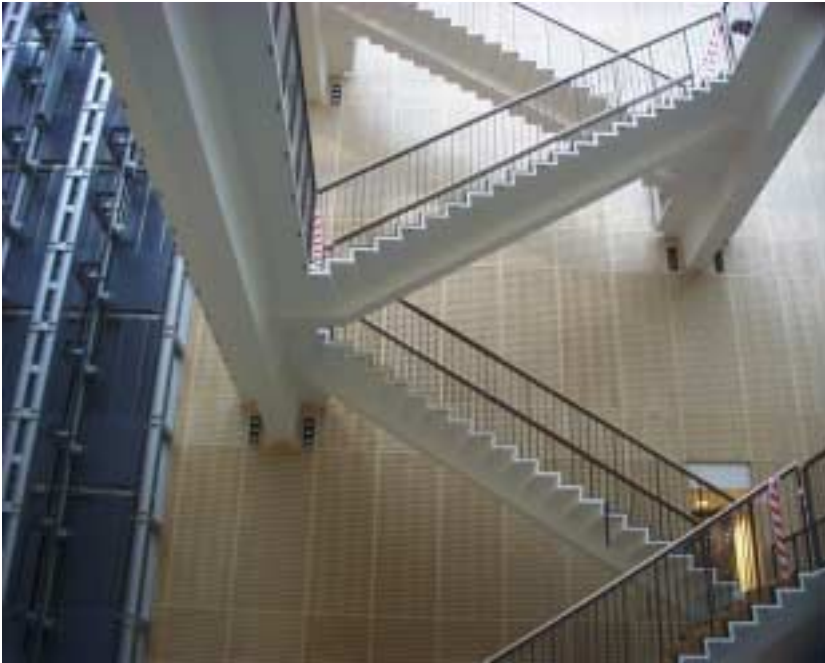
CRC trappe og gangbro i Aarhus produceret af Beton-Tegl og tegnet af 3xNielsen.
