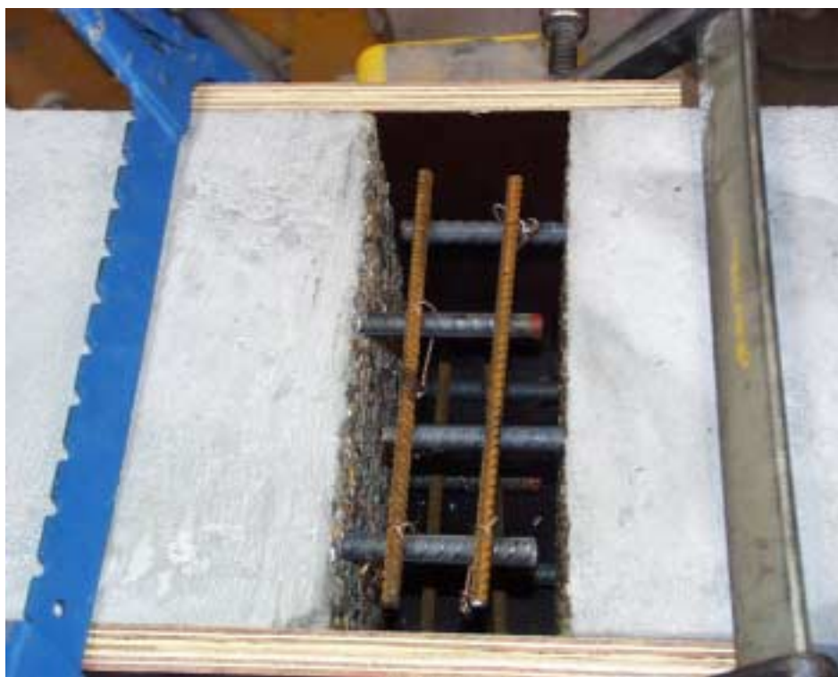
Figur 2 Bjælke dele med udragende \varnothing 12 armeringsjern før sammenstøbning med CRC JointCast.
